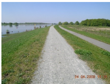
Bild 2: Deich mit Radweg
